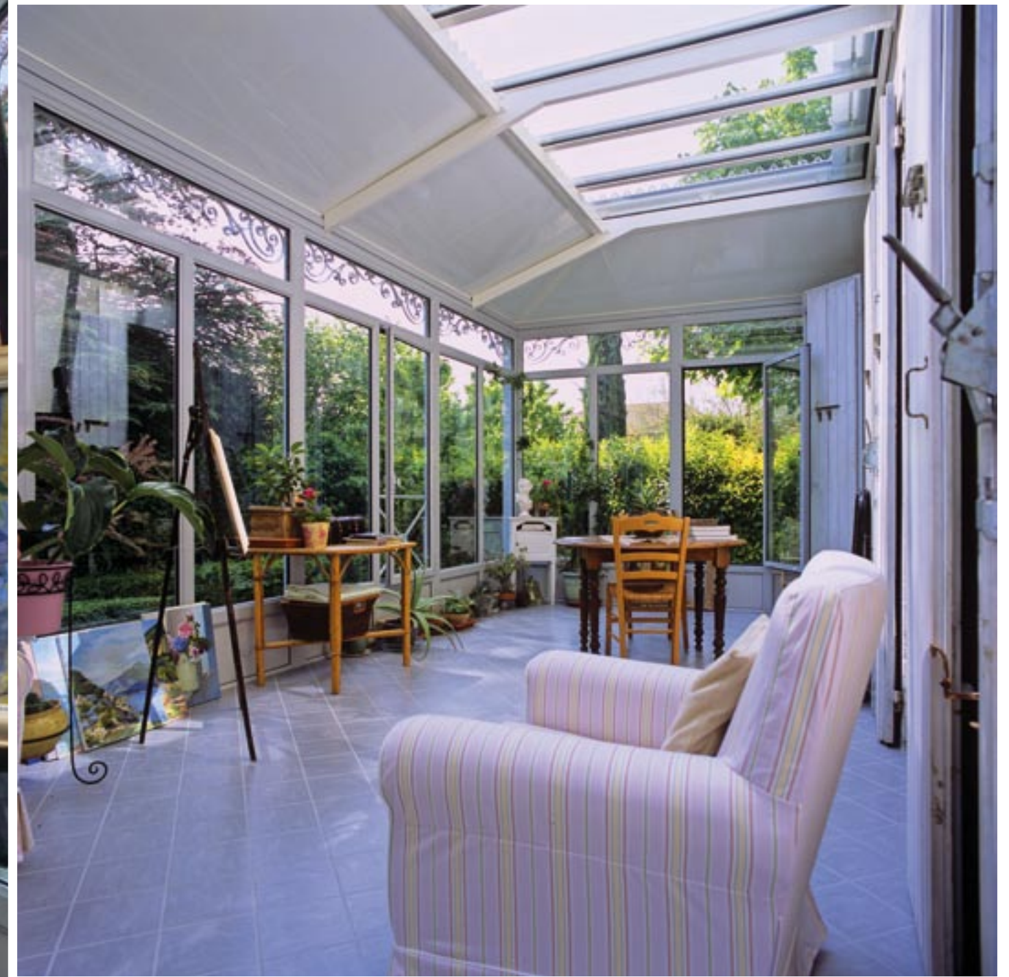
Ci-dessus : en toiture, des panneaux sandwich isolants bordent le puits de lumière.
